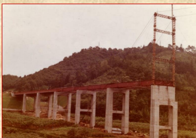
中央自動車道 中野橋の現場（架設中）
