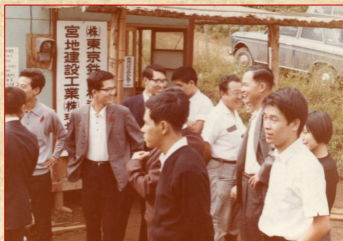
当時、大月市富浜町内で架けていた中野橋の現場事務所。 日本道路公団（現在のNEXCO）発注の橋長348mの橋。
