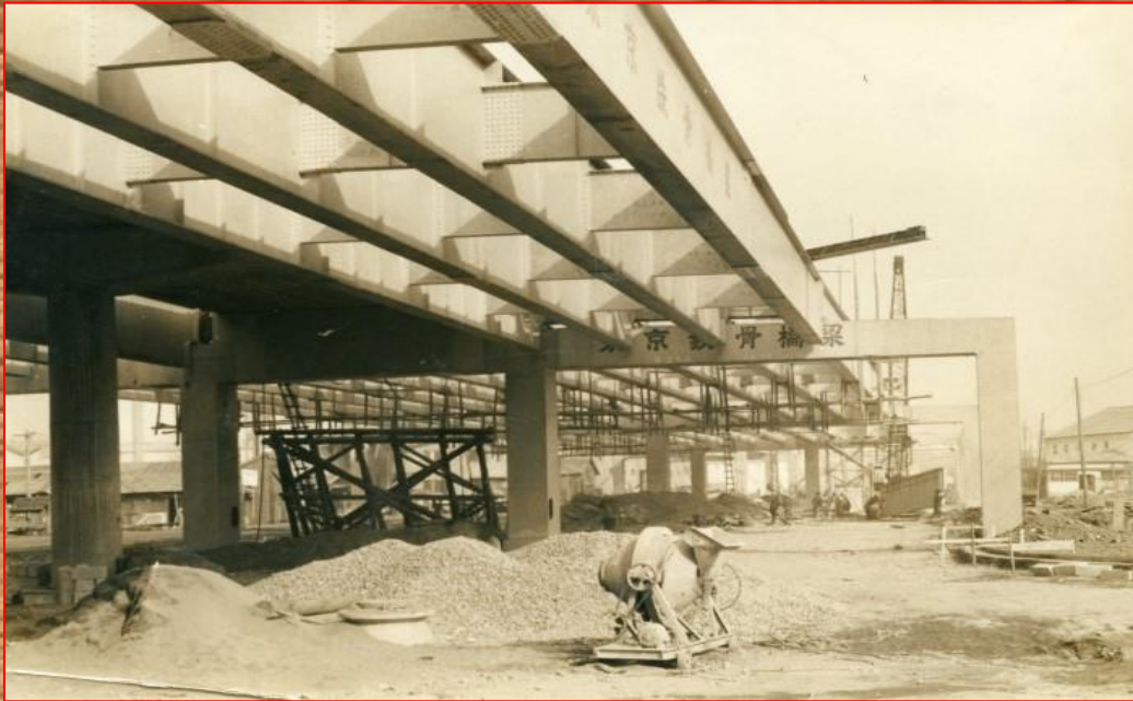
1961年(昭和36年) 架設中
