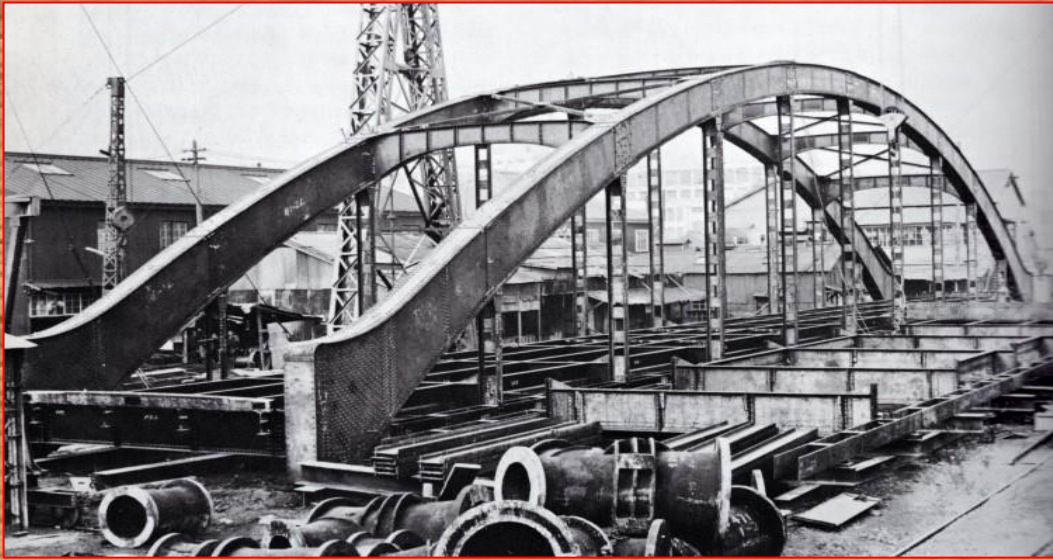
1934年(昭和9年) 仮組立 芝浦工場
