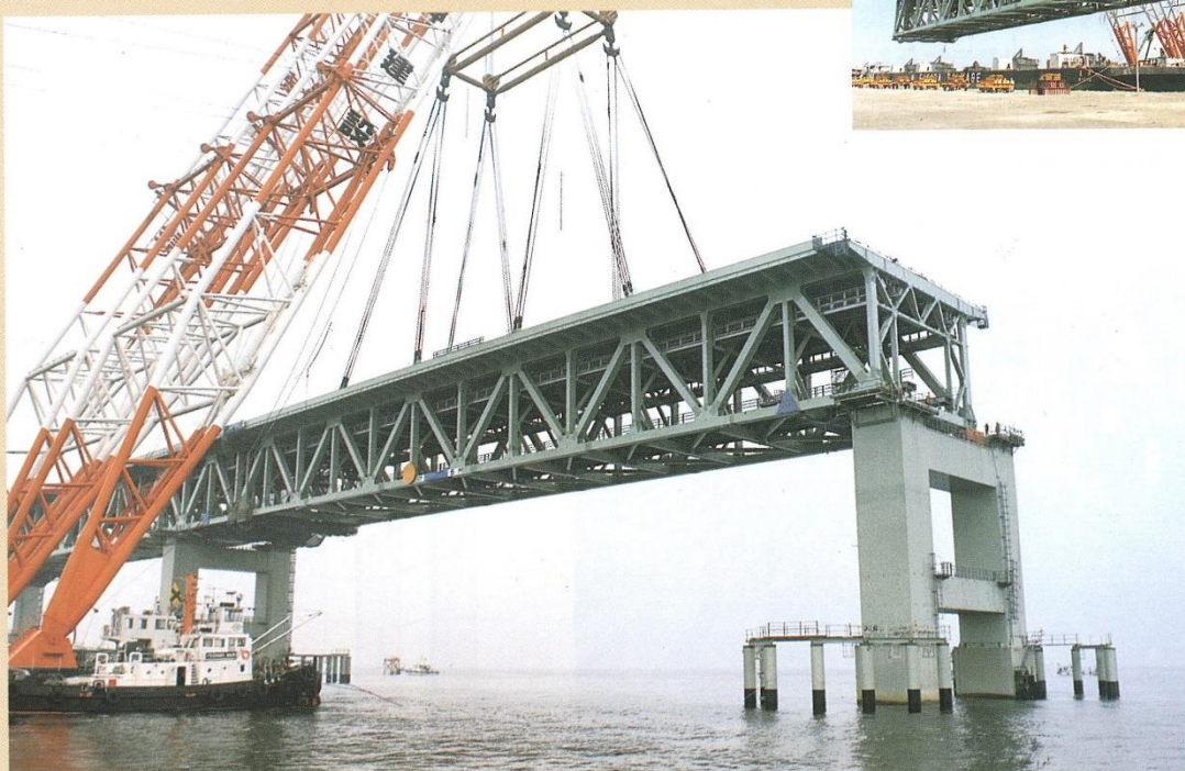
大ブロック架設
