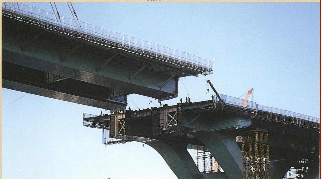
大ブロック架設
