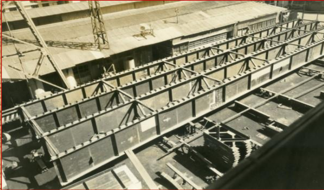
1959年(昭和34年) 仮組立 芝浦工場
