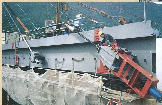
ケーブル取り付け
