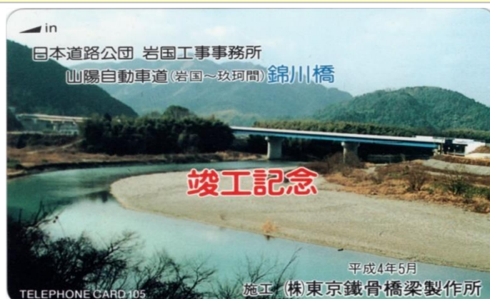
錦川橋(1992年竣工) 山口県岩国市
