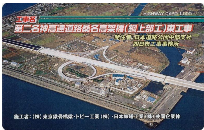
桑名高架橋(2001年竣工) 三重県桑名市
