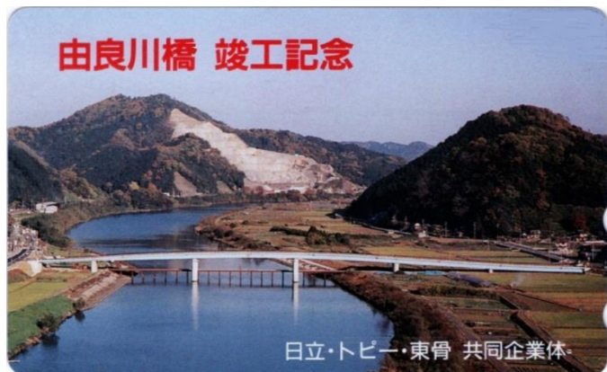
由良川橋(1997年竣工) 京都府舞鶴市
