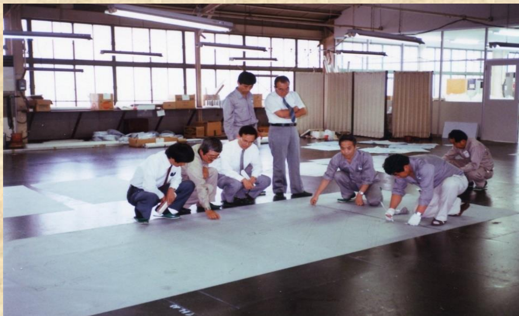
1991年(平成3年) 取手工場 現寸場 -横浜ランドマークタワーの原寸検査-
