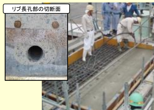
実物大試験体によるコンクリート充填試験状況
