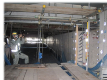
下部工鉄筋の計測
