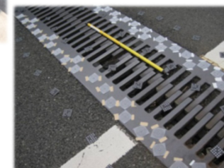
伸縮装置の計測 （フェイスプレートの取替え）
