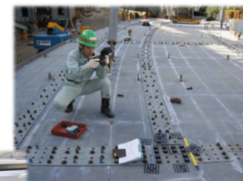
後製作添接板の計測
