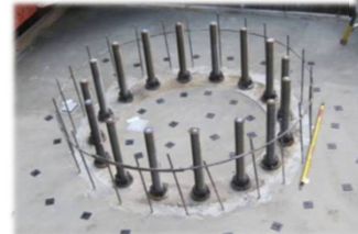
下部工アンカーボルト計測
