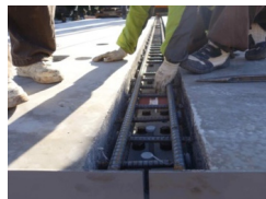
接合部 ボルト締付、補強筋設置
