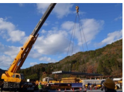
プレキャスト版敷設
