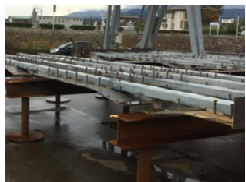
鋼板パネル製作
