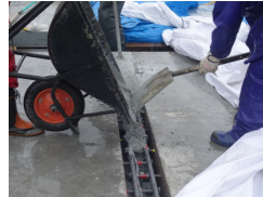
接合部 LMFC打設
